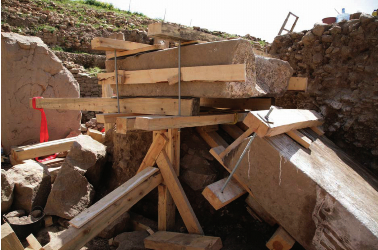
Bild 9: Pfeileroberteil nach dem Kippen in die Waagerechte.
