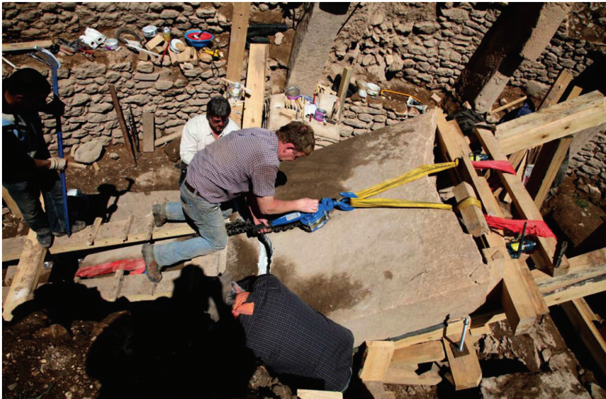
Bild 11: Zusammenziehen der beiden Hälften des Pfeilers.
