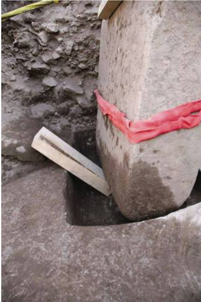
Bild 4: Der ausgeräumte Köcher mit der sehr geringen Einbindetiefe.
