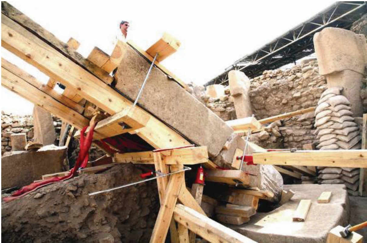
Bild 10: Versuch der exakten Ausrichtung, mit horizontaler Sicherung.
