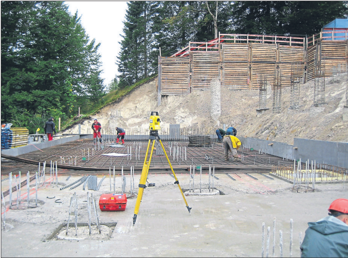
370 Bohrpfähle waren nötig.
