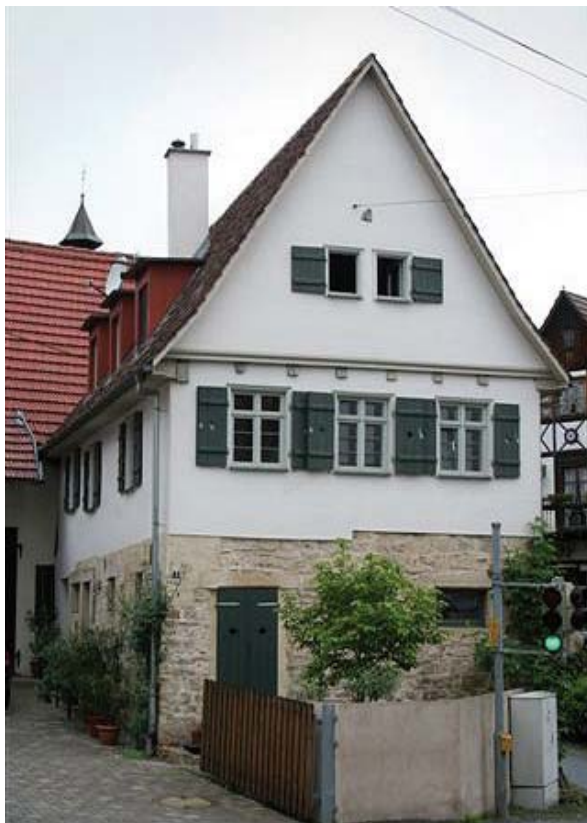
Stuttgart-Plieningen, Goetzstraße, Wohnstallhaus um 1800 Denkmalpreis 2005 u. a. für die denkmalgerechte energetische Ertüchtigung mit Aufdachdämmung, Innendämmung im massiven Sockelgeschoss (Schilfrohr, Kalkputz, Wandheizung), Außen- dämmung der Fachwerkobergeschosswände (kleinteiligen Mine- ralfaserdämmplatten), Vorsatzfenster, Modernisierung der Hei- zungsanlage Foto: Ulrike Roggenbuck-Azad, Landesamt für Denkmalpflege im Regierungspräsidium Stuttgart
