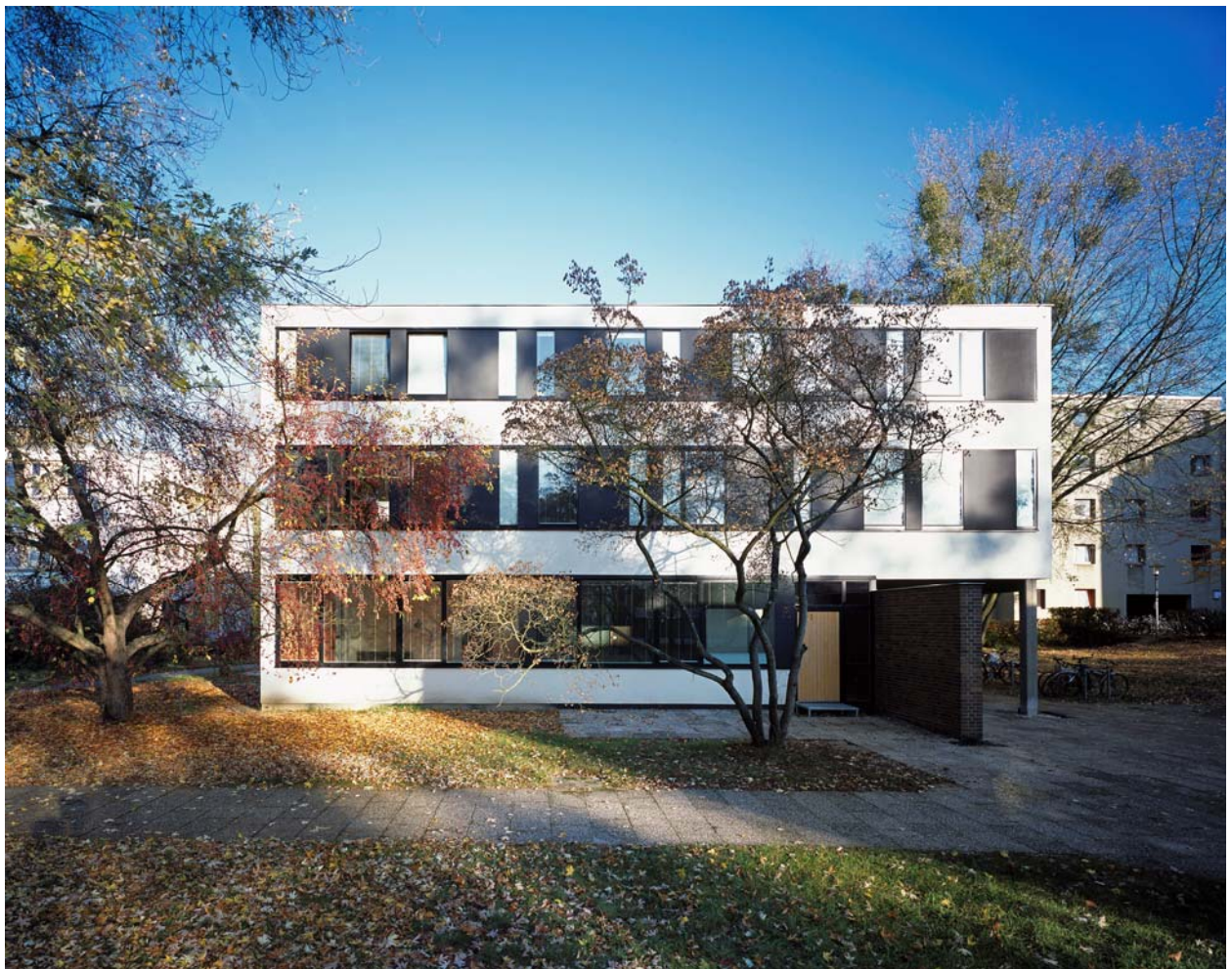
Berlin, Studentendorf in Schlachtensee, Architekten: Fehling, Gogel, Pfankuch, Berlin, 1957-1959. Energetische Maßnahmen: Flachdachdämmung, thermisch getrennte Stahlprofile mit 3-fach Verglasung, Innendämmung mit Mineralschaumplatten, geregelte Lüftungsanlage mit Wärmerückgewinnung, zentrale Heizungsanlage mit Biogasbetrieb und BHKW (ab 2012), Foto: Mila Hacke, Berlin
