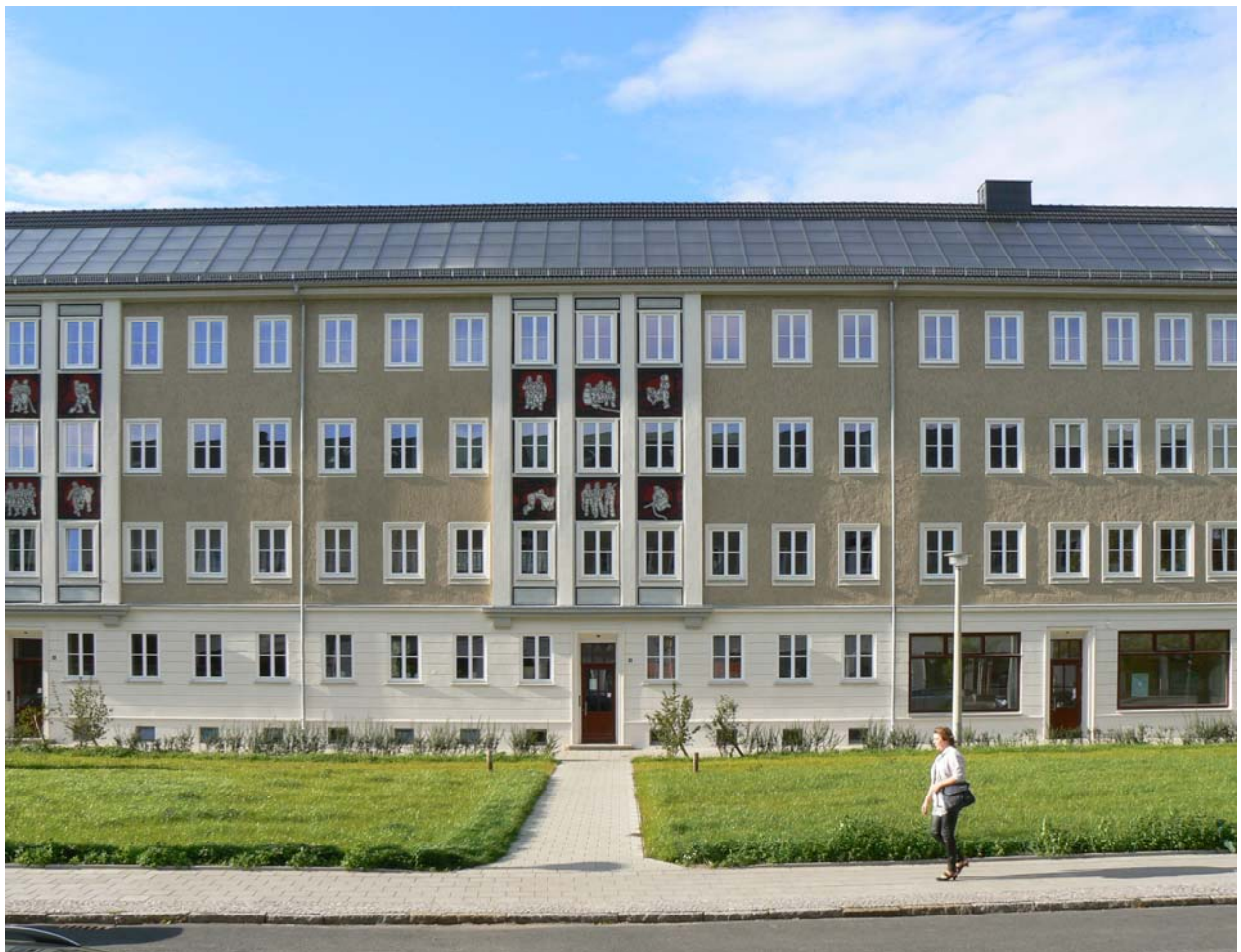
Sangerhausen (Landkreis Mansfeld-Südharz,) Siedlung „Am Bergmann“, 1952/53 erbaut, energetische Instandsetzung 2008-2010 im Rahmen der IBA Stadtumbau 2010: innere Zellulosedämmung, mechanische Lüftung mit Wärmerückgewinnung, Fußbodenheizung im Niedertemperaturbereich, in die Dachhaut integrierte Solaranlage, Foto: Ulrike Wendland
