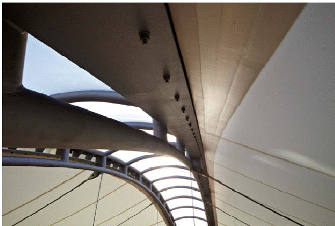
Bild1 : Innenraum des textilen Membrandaches mit transparenten und durchscheinenden Membran zur Tageslichtnutzung
