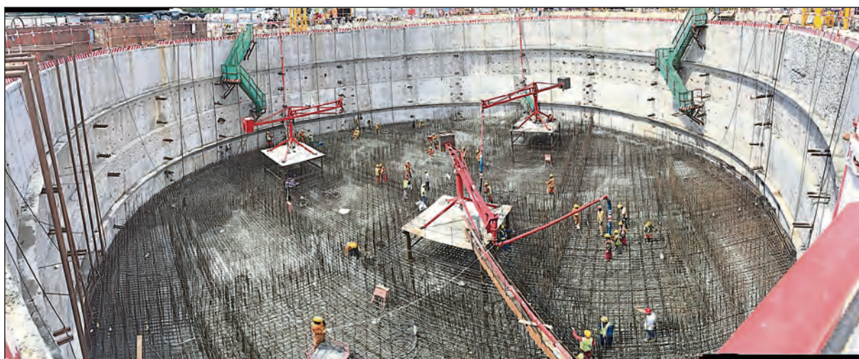
Betonarbeiten im Schacht des Ankerblocks.
