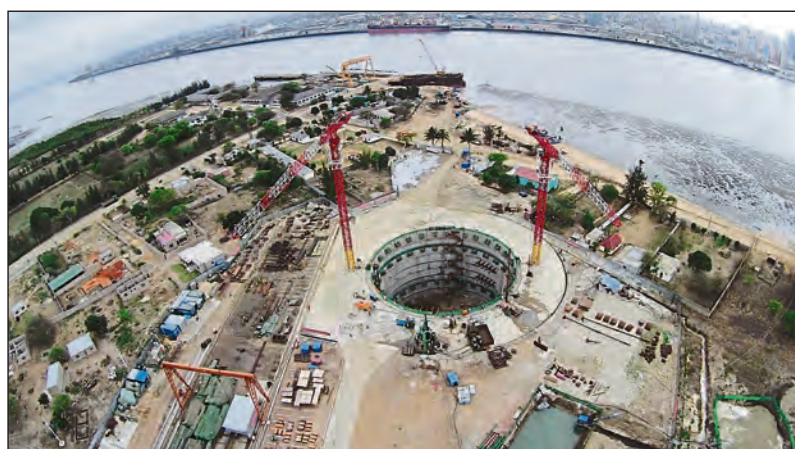
Die Baugrube für das Fundament des Ankerblocks im Süden.
