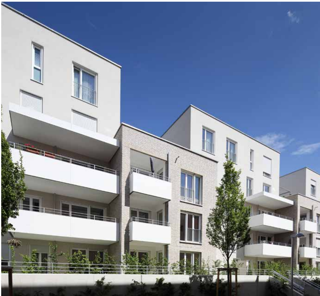
Abbildung oben: Mehrfamilienhaus in Ulm
