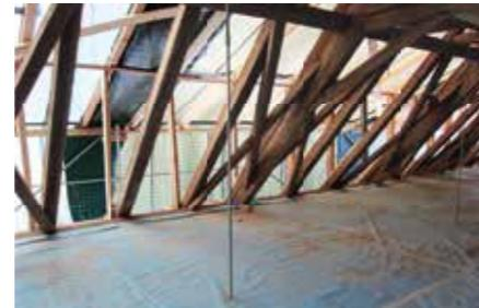
Damit die Lastabtragung während der Bauzeit gesichert war, wurde die Zerrbalkenlage an provisorische Sprengwerke im Dachgeschoss angehängt, die Dachkonstruktion spannte damit frei über die gesamte Gebäudebreite. Um Standsicherheit, Schall- und Brandschutzanforderungen erfüllen zu können, musste bei der großen Spannweite ein Deckensystem mit geringen Eigenlasten gewählt werden. Die eingebaute Ziegelleihgedecke erfüllt diese Anforderungen optimal.
