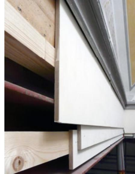
Da ein direktes Anbinden an die einst sichtbare hölzerne Tragstruktur – Konstruktion an Konstruktion – nicht umsetzbar war, musste eine Detailausbildung für einen schlüssigen Übergang zwischen der Holzdecke und dem neuem Tragwerk gefunden werden, die den Bestand und dessen Maßstäblichkeit ohne gestalterische Brüche an die Stahlkonstruktion heranführt. Dadurch nimmt sich diese im Innenraum zurück, stärkt aber gleichzeitig die tektonische Wirkung der Kuppel.
