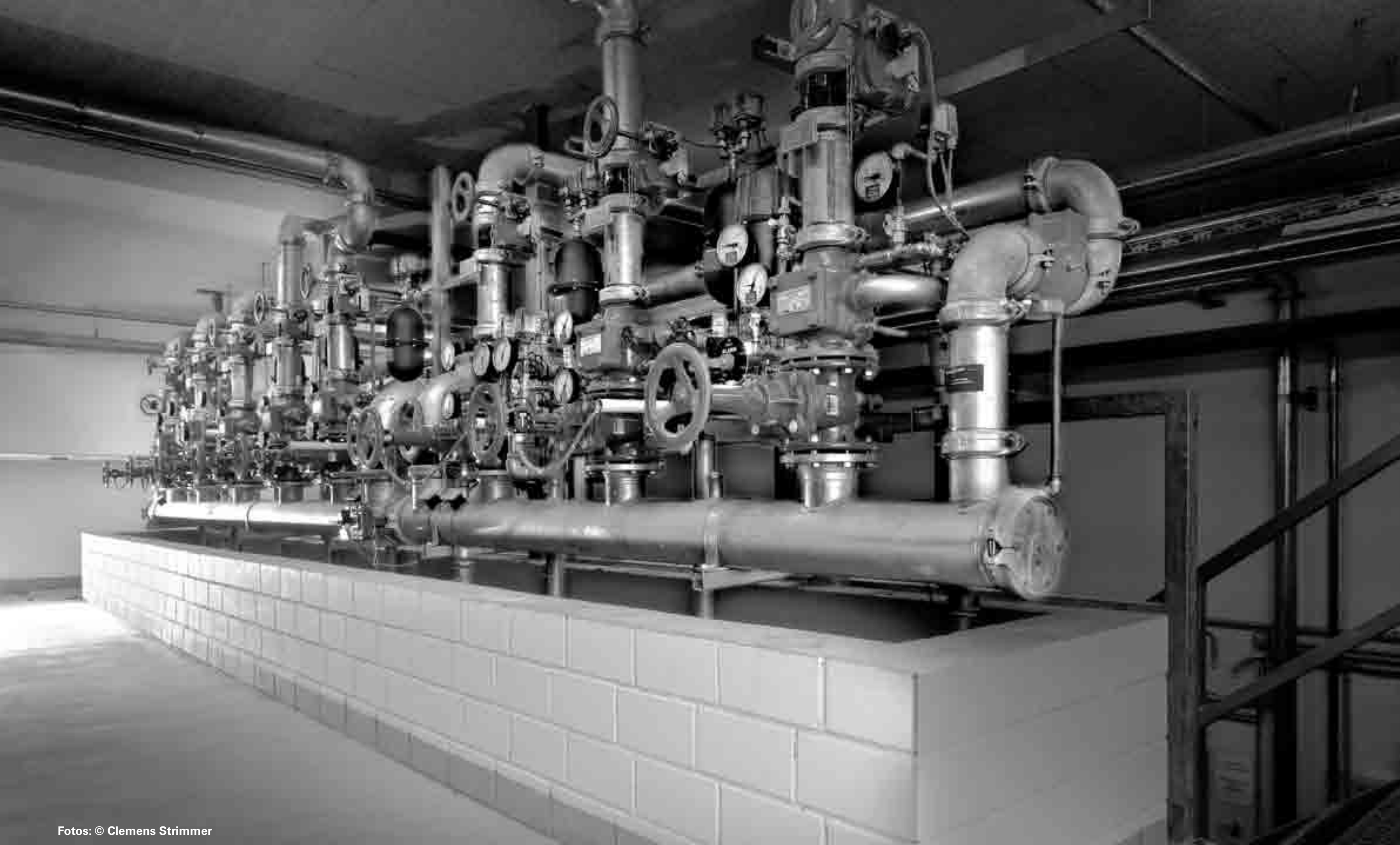
Sprinkleranlage in einem Hochhaus, München
