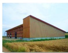
Bei der Konstruktion handelt es sich um eine Halle, die traufseitig aus Stahlbeton-Kragstützen und auf der Firstseite aus Pendelstützen besteht. Durch den Einsatz der ökologischen Holzkonstruktion können im Vergleich zu anderen Baustoffen erhebliche Kosten eingespart werden. Gleichzeitig ist das Bauobjekt optisch ansprechend. Die neue Bergehalle hat eine Länge von rund 72 m und ist ca. 16 m breit. Somit beläuft sich die Nutzfläche auf rund 1.180 m<sup>2</sup>.
