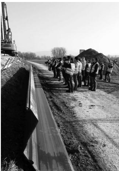
Baustellenbesichtigung in Winzer.
