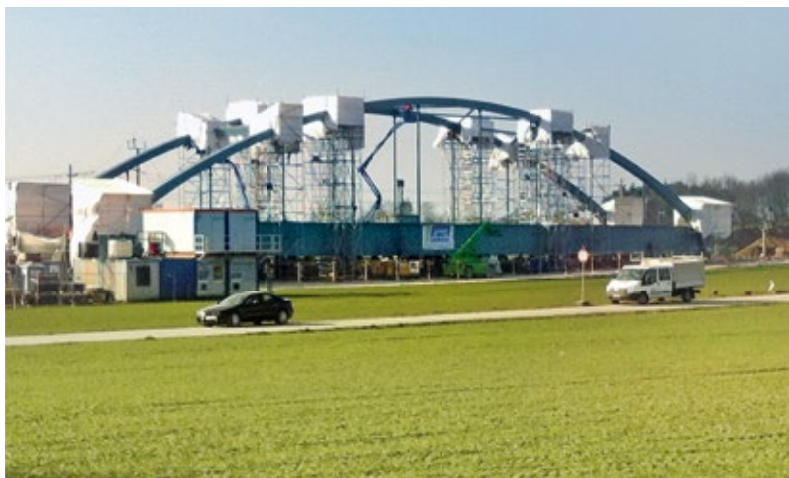
Teilbauwerk Ost, Stahlstabbogenbrücke
